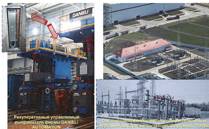
Рис. 6. Решения по электроснабжению производства
